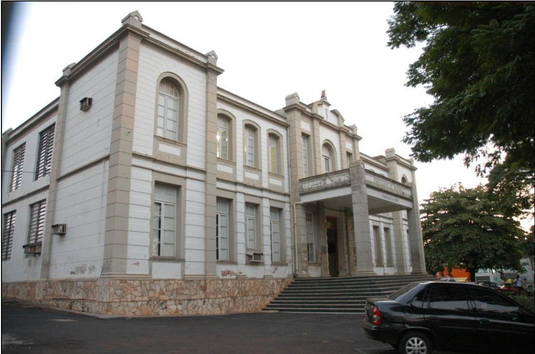
Figura 248-Prédio da FMTM em 2005
